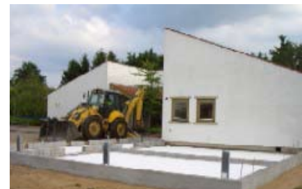
Tilbygningen mod nord er i gang
